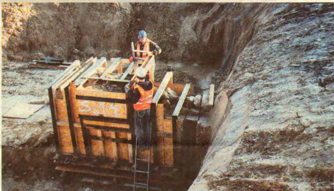
Gut verpackt auf Stahlträgern und -platten ruhend und mit Holz verschalt, wartet der antike Revisionsschacht auf seine Bergung aus der Baugrube.
