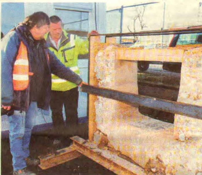
An einer dünnen Scheibe zeigen Cornelius Olbert (l.) und Marko Basenau, wie der Kanal vor der Bergung gesichert wird.
