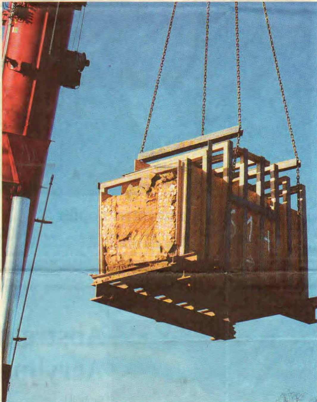
Mehr als 20 Tonnen wiegt das mit Sand und Lehm gefüllte größte Stück des Römerkanals, das mit dem Autokran aus der Grube gehoben wird. Es soll später an den Fundort zurückkehren. Fotos: Engels
